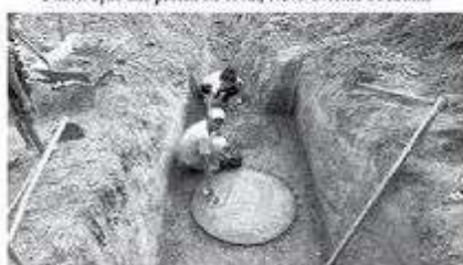
Montagem da base da fossa, Bertópolis
