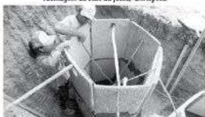
Montagem das placas, Bertópolis
